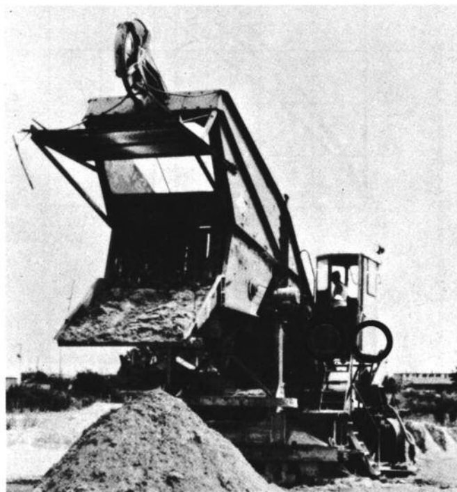
Sospensione della cabina di una macchina movimento terra
